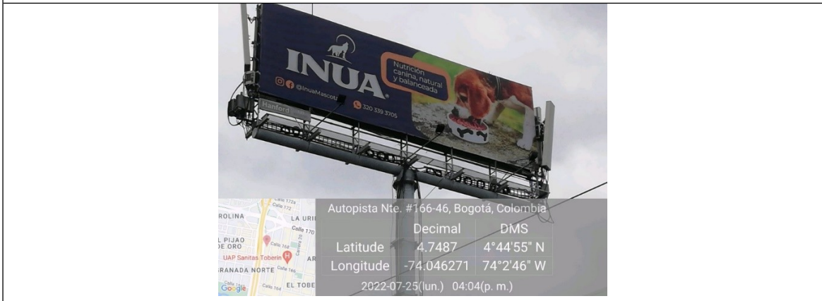
Foto 2. Vista del panel orientación Sur-Norte y de la estructura de la valla, en buenas condiciones y estable.
